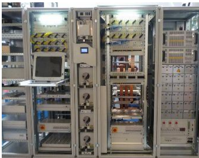
Рисунок 5.2 – Технологічні шафи диспетчерського пункту SCADA-системи
