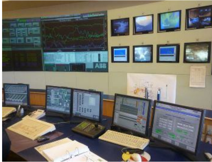
Рисунок 5.3 – Диспетчерський пульт із SCADA-системою
